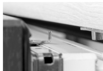
MECHANIZM STOPNIOWANEGO UCHYŁU pozwała na uchYLENIE okna w 5 stopniach
